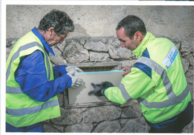
Réparation de la porte d'une niche et calorifugeage du compteur contre le gel.
