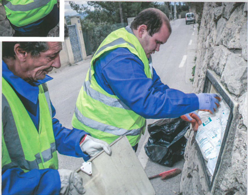
Réparation de la porte d'une niche et calorifugeage du compteur contre le gel.
