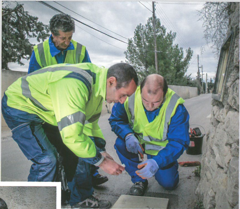
Réparation de la porte d'une niche et calorifugeage du compteur contre le gel.
